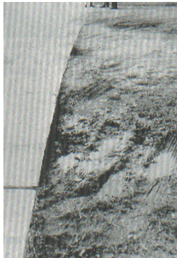
Figura C27-b. Desnivel carril / berma de severidad media.
