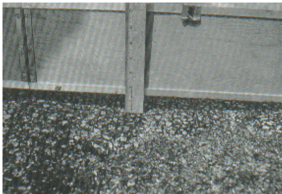
Figura A15-c. Ahuellamiento de alta severidad.
