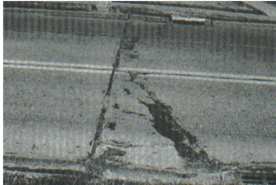
Figura C34-b. Punzonamiento de severidad media.
