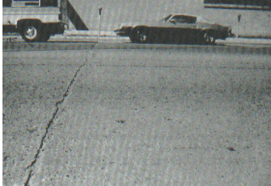
Figura C39-a. Descascaramiento de junta de baja severidad.
