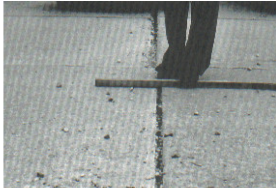
Figura C25-a. Escala de baja severidad.
