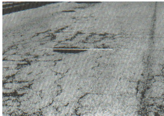
Figura A13-b. Hueco de severidad media.
