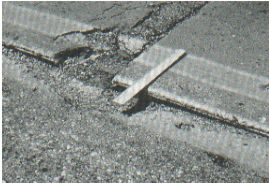
Figura C27-a. Desnivel carril / berma de baja severidad.
