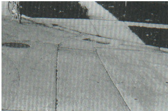
Figura C29-a. Parche grande y acometidas de servicios públicos de baja severidad.
