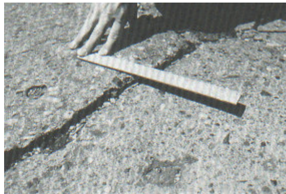
Figura C25-b. Escala de severidad media.
