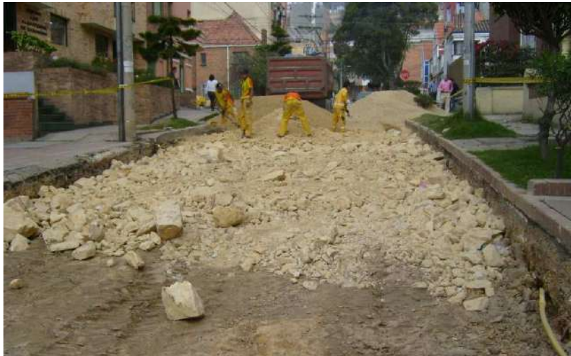
Figura 3.5 Vías intervenidas en la localidad de Chapinero - Mejoramiento con rajón
