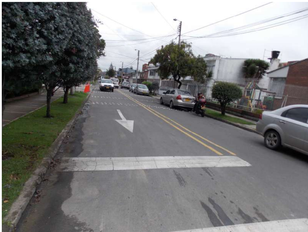
Figura 7.1 Pavimento flexible en vías locales
