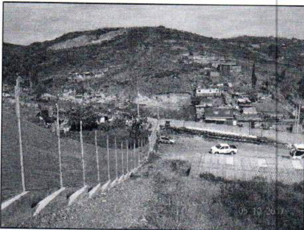
Fotografía 12 Condiciones actuales de la vegetación sobre el Talud 3
