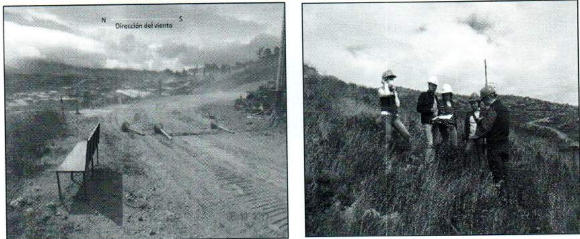
Fotografía 10 Condiciones actuales de arrastre por material particulado
