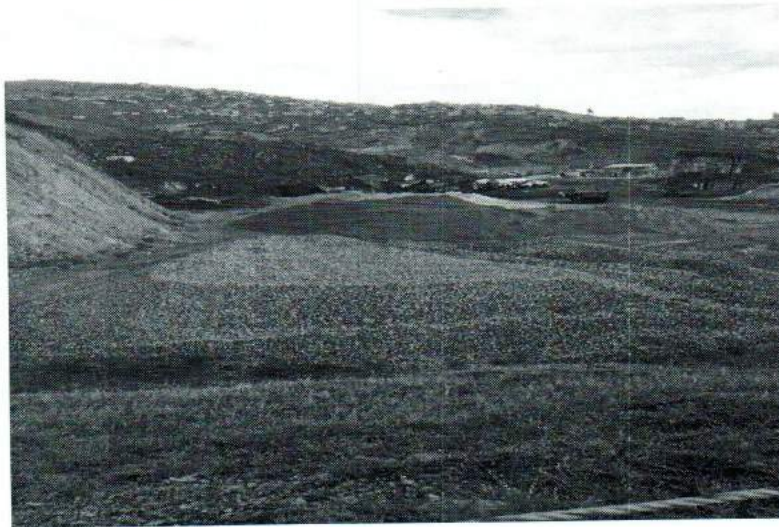
Fotografía 6 Terraceo de los acopios de los materiales
