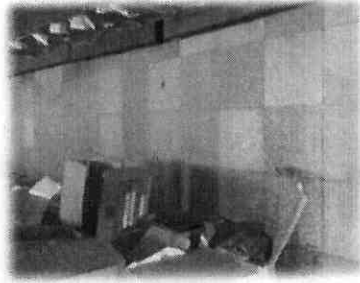
Imagen 66. Detalle de los pisos en la sección 4 de la bodega SOP.
