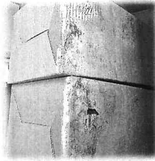
Imagen 102. Cajas con deterioro biológico de la bodega 2.
