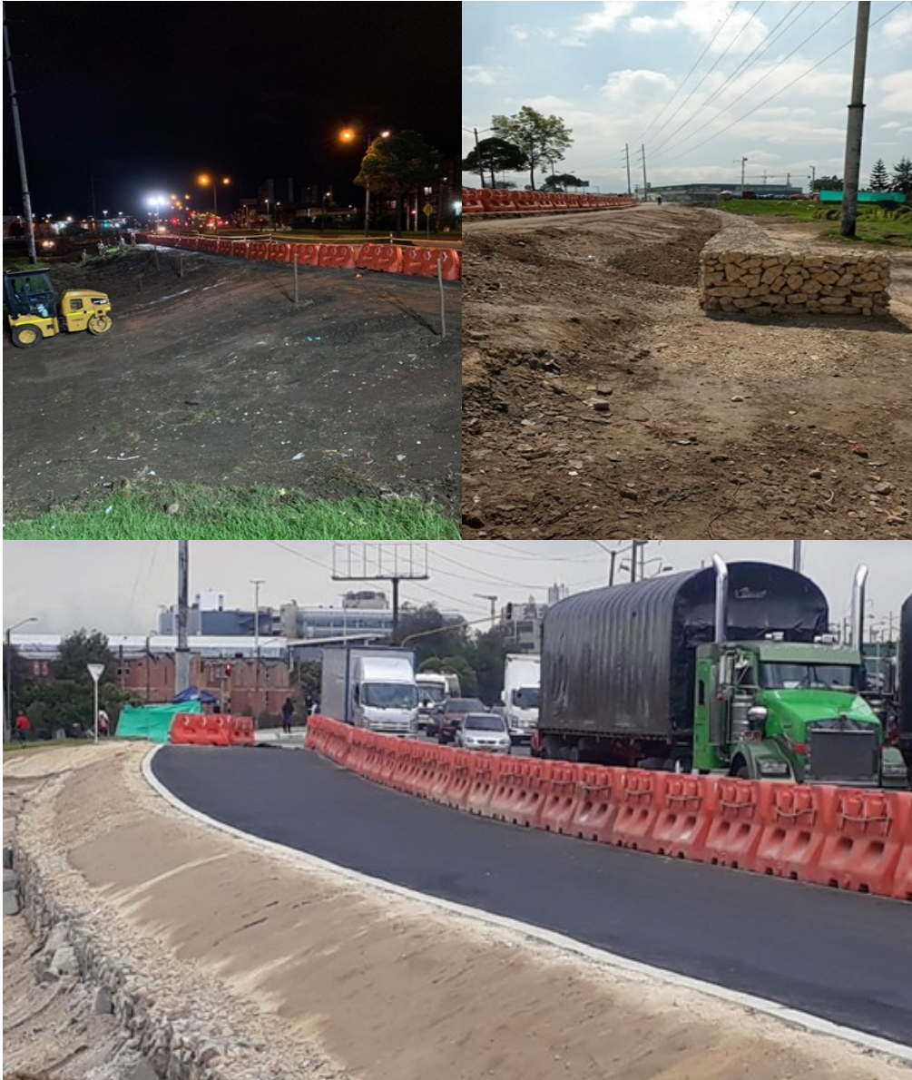
Tramo en tangente Calle 13 entre Carrera 97 y Alameda el Porvenir (obras de conformación de taludes e instalación de carpeta asfáltica)
