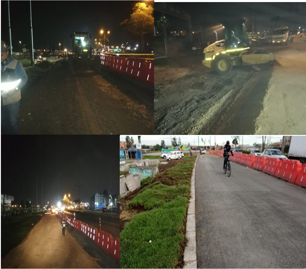
Tramo en tangente Calle 13 entre Carrera 100 y Carrera 104 (obras de conformación de taludes e instalación de carpeta asfáltica)
