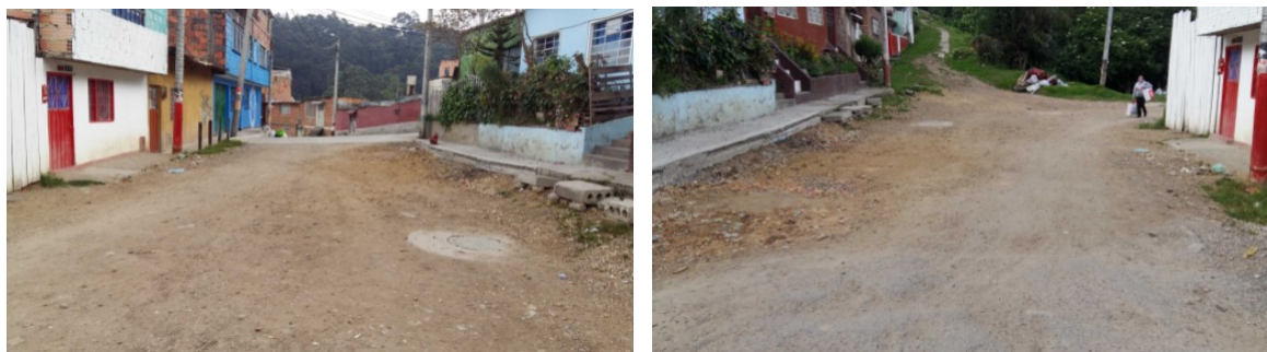
Figura 1 – Carrera 20 Este entre Calle 10 Sur y Calle 13 Sur
