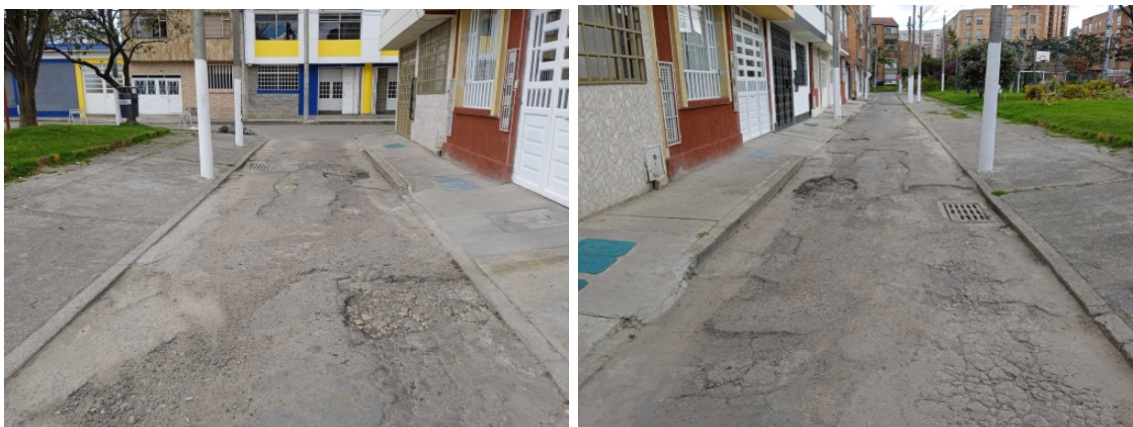
Figura 6 – Carrera 39 entre Calle 2F y Avenida Calle 3
