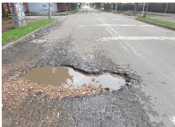
Figura 1 – Calle 154A entre carrera 92 y carrera 94
