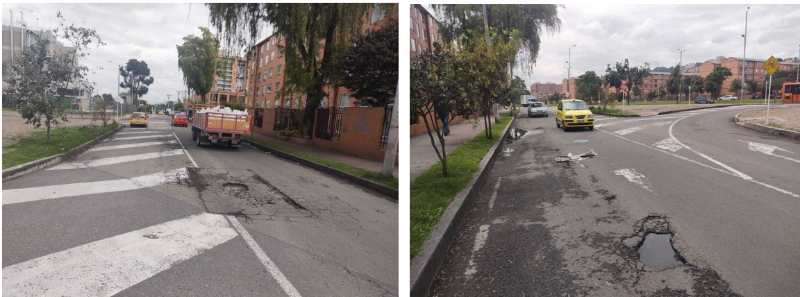
Figura 1 – Carrera 68 entre Avenida Carrera 72 y Calle 169A
