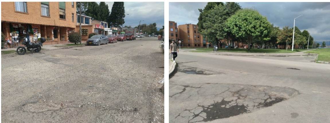
Figura 1 – Calle 86A entre Carrera 113 y Carrera 115
