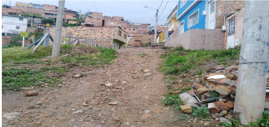
Figura 1 – Calle 68 Sur entre carrera 18 y carrera 18A
