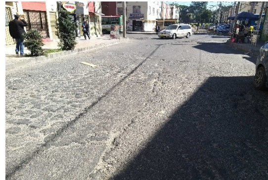
Carrera 113 entre calle 78F Bis y calle 79
