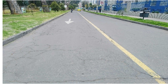
Transversal 71B entre calle 9D y avenida calle 12
