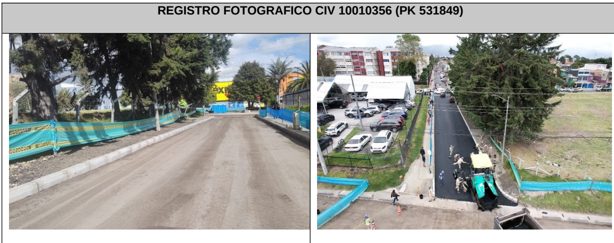
Ilustración 1. Calle 71C con carrera 96 REGISTRO FOTOGRAFICO CIV 10010356 (PK 531849)
