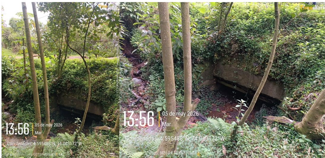
Fotos 4 – 5. Se observa costado derecho (sentido de ingreso) estructura tipo box coulvert, sitio de acceso quebrada Padre Jesús (de acuerdo con SIGIDU – SIGMA)
