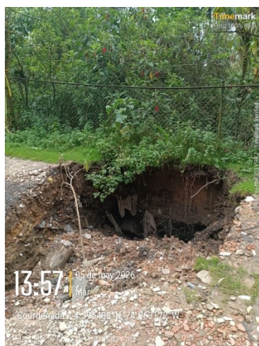
Fotos 6 – 7. Falla en la estructura de soporte o placa de la estructura tipo box coulvert, permitiendo el fallo en el relleno de la vía, materiales de relleno se observa estratos consolidados de escombros con una altura mayor a los 50 cm, no se perciben hombros de la estructura, no se logra identificar estado del descole de la estructura, placa, dentellón, solera, ni aletas.
