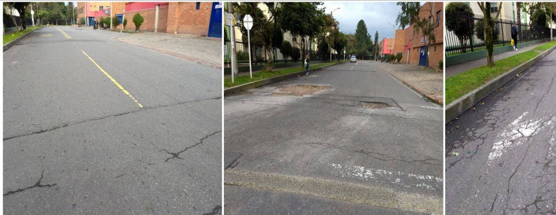
Ilustración 2, Registro fotográfico del estado del tramo vial
