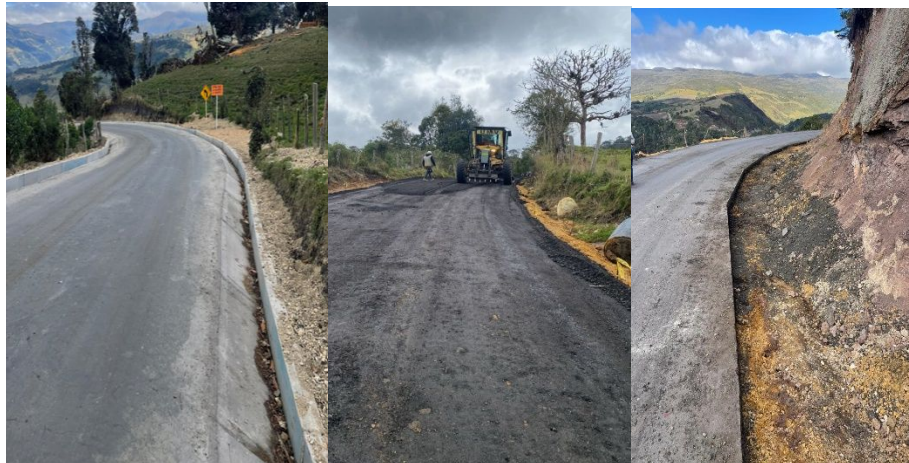
Ilustración 6 Registro fotográfico obras de calzada.
