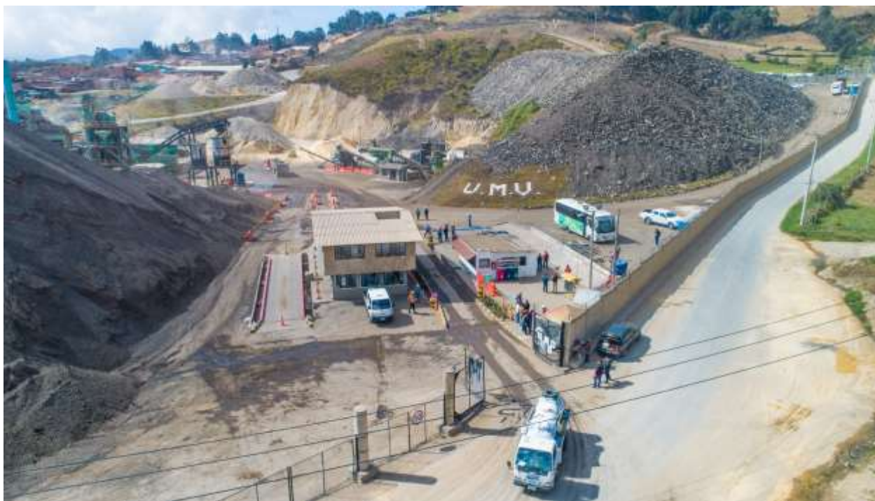
Fotografía aérea de la entrada al Predio “LA ESMERALDA PLANTA EL ZUQUE” propiedad de la UAERMV
