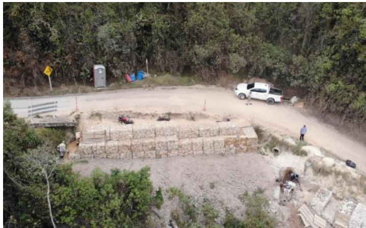
Ilustración 11. Construcción de muro en gaviones. Foto 12-03-24. Fuente OCI-UMV
