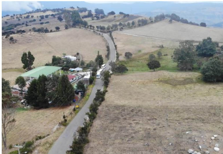
Ilustración 17. K7+500 hacia atrás en el tramo Unión-Tunales. Pavimento Terminado. Foto 12-03-2024. Fuente OCI-UMV.
