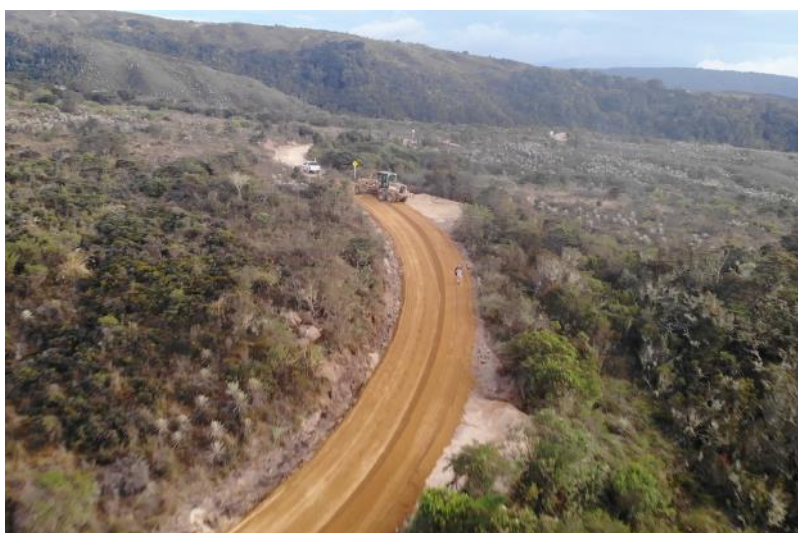
Ilustración 29. Extendido de base. Foto 12-03-24. Fuente OCI-UMV.
