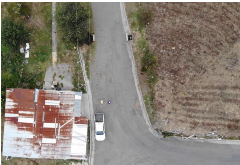
Ilustración 18. K7+500 (Final) Unión-Tunales con Cuneta Terminada. Foto 12-03-2024. Fuente OCI-UMV.
