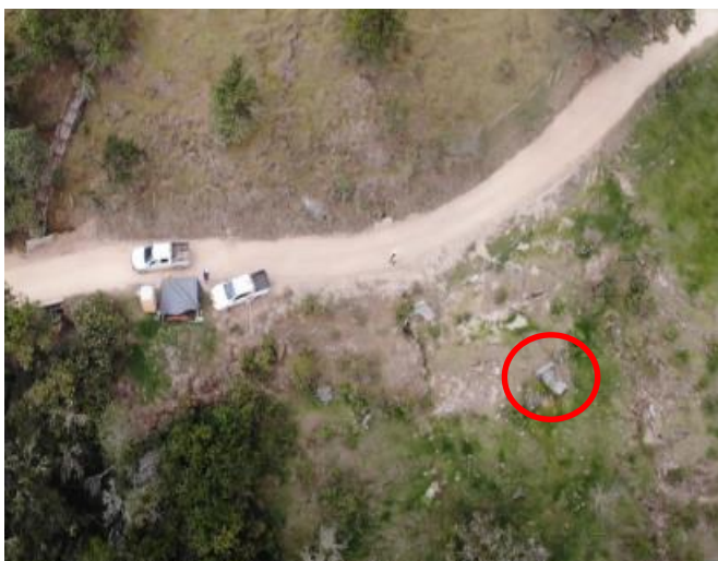
Ilustración 7. Deslizamiento en el K0+850 del tramo Unión-Tunales.
