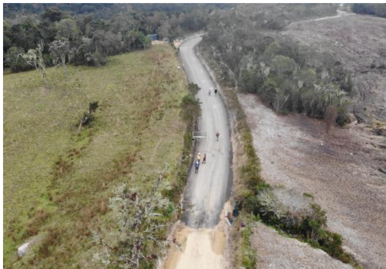
Ilustración 24. Tramo Capitolio. Pavimento terminado. Pendiente Cunetas. Foto 12-03-24. Fuente OCI-UMV.
