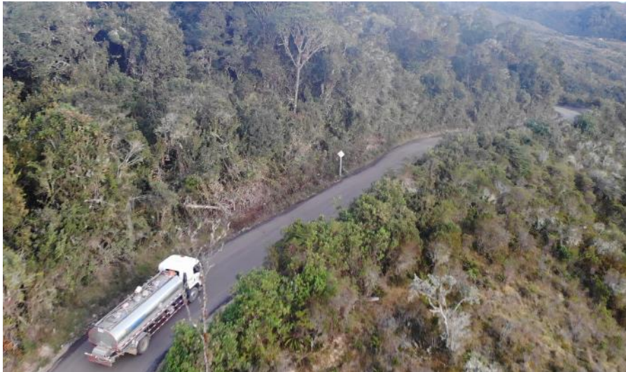
Ilustración 26. Tramo San Antonio. Pendiente construcción de cunetas. Foto 12-03-24. Fuente OCI-UMV.
