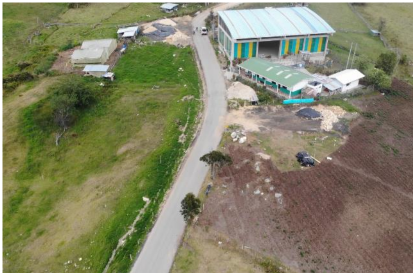
Ilustración 15. Tramo con pavimento terminado en la escuela Tunales. Foto 12-03-2024. Fuente OCI-UMV
