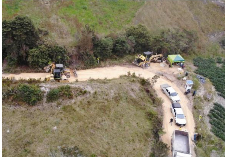
Ilustración 22. Tramo Capitolio. Extendido de base. Foto 12-03-2024. Fuente OCI-UMV.
