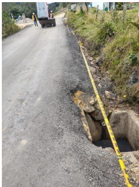
Ilustración 25. Tramo Capitolio. Pendiente realce de cabezales. Foto 12-03-2024. Fuente OCI-UMV.
