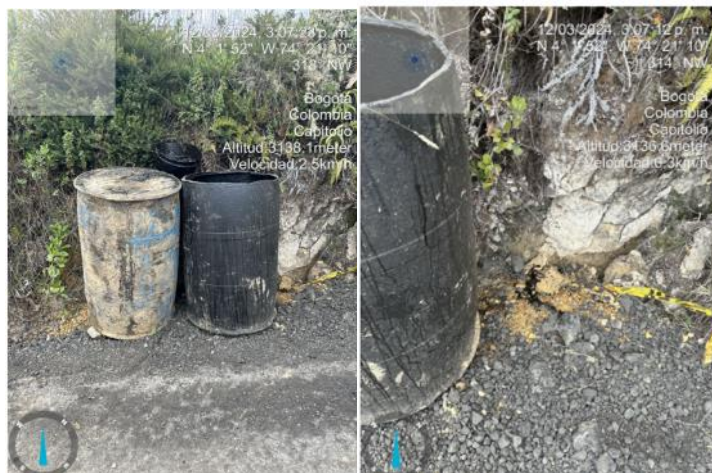
Ilustración 19. Tramo Unión-Tunales. Canecas en mal estado y sin adecuado almacenamiento. Foto 12-03-24. Fuente OCI-UMV.
