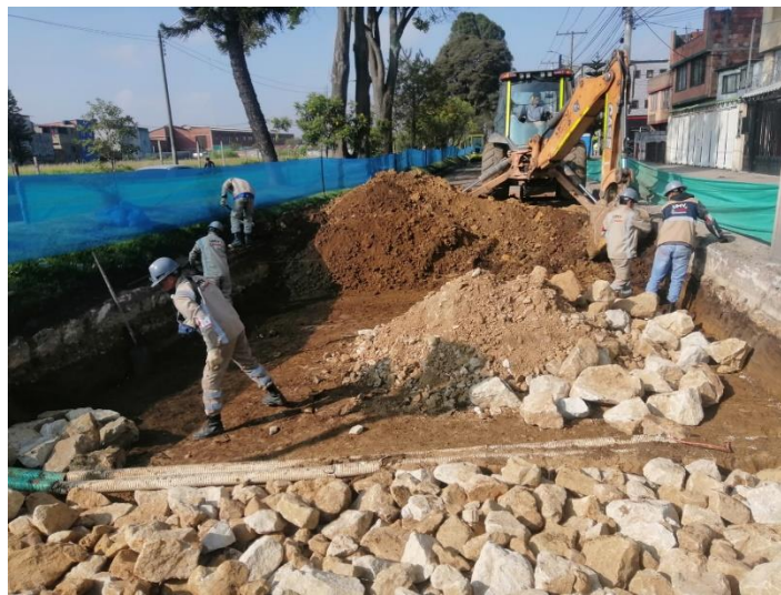
Figura 1. 13. Instalación de rajón para mejoramiento de la subrasante.
