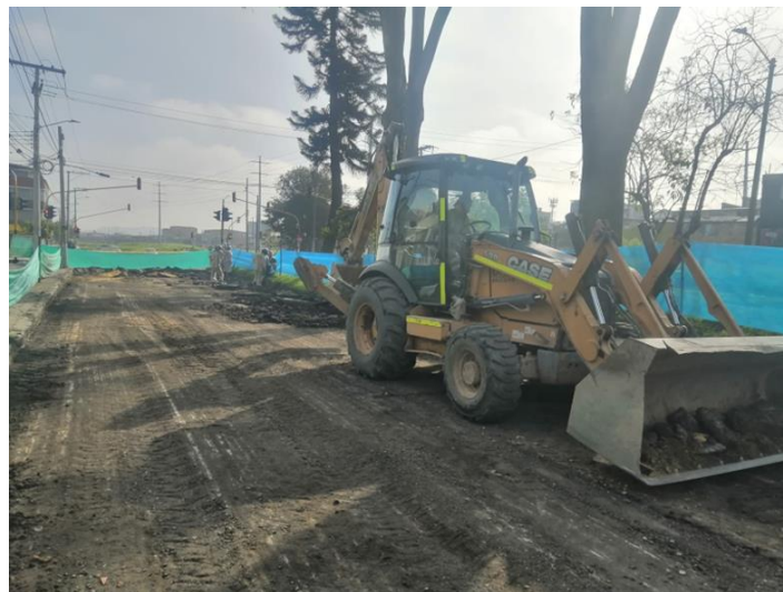
Figura 1. 9. Excavación del remanente del fresado.
