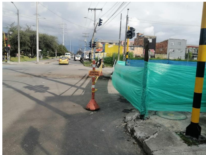
Figura 1. 7. Cerramiento del tramo.
