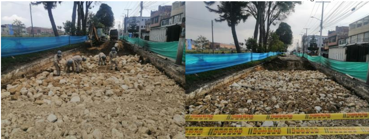
Figura 1. 14. Avance de la instalación del mejoramiento de la subrasante.
