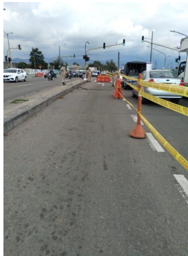
Figura 1. 6. Instalación de Plan de Manejo de Tránsito.
