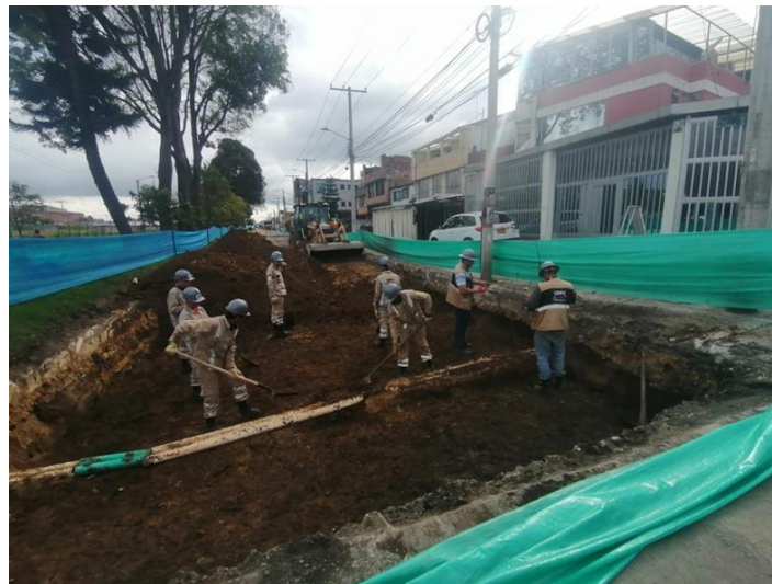
Figura 1. 11. Excavación manual del tramo.
