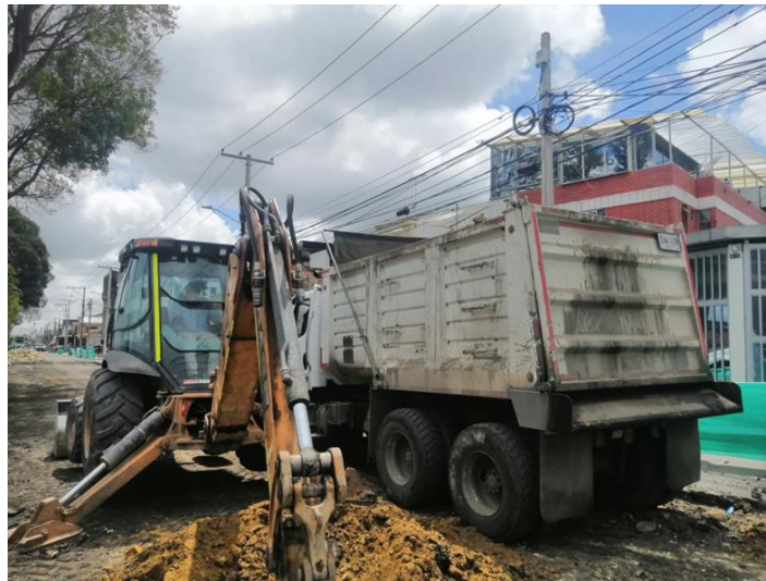
Figura 1. 10. Excavación del tramo.
