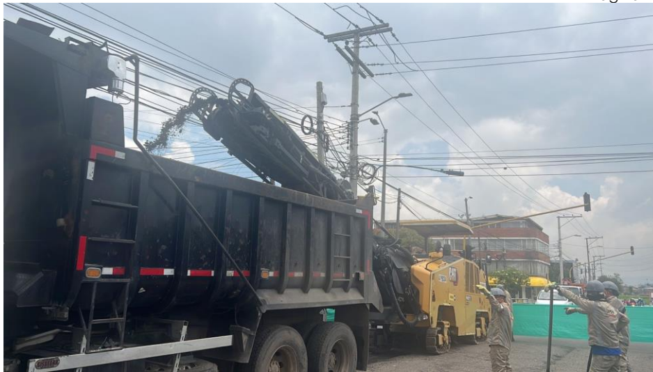
Figura 1. 8. Fresado de la carpeta asfáltica.
