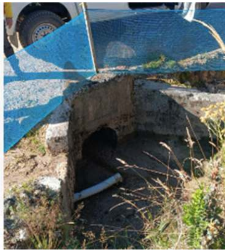
Fuente: Alcantarilla tramo Capitolio – Equipo OCI
