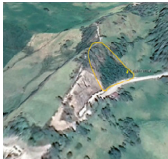
Figura 6: A la izquierda alternativa geotécnica tradicional. En polígono amarillo obra de geotecniabio. Ingeniería Verde Fuente: Gerencia de infraestructura rural
