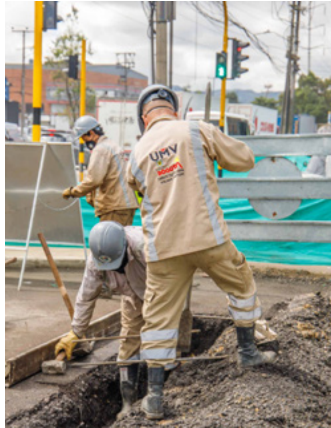
Foto 1: Trabajadores en obra Fuente: UMV
