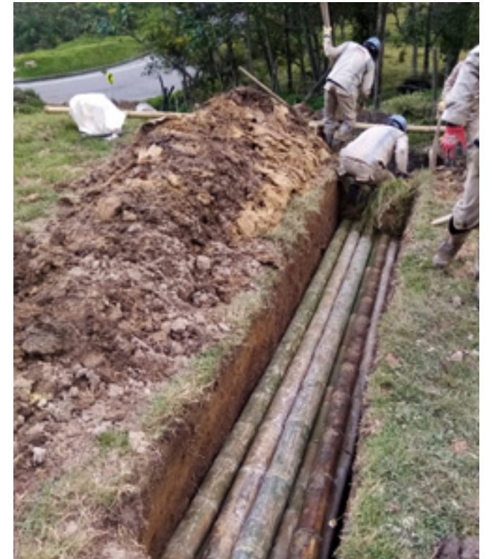
Foto 1: Tramo choachi 1 Fuente: URMV
