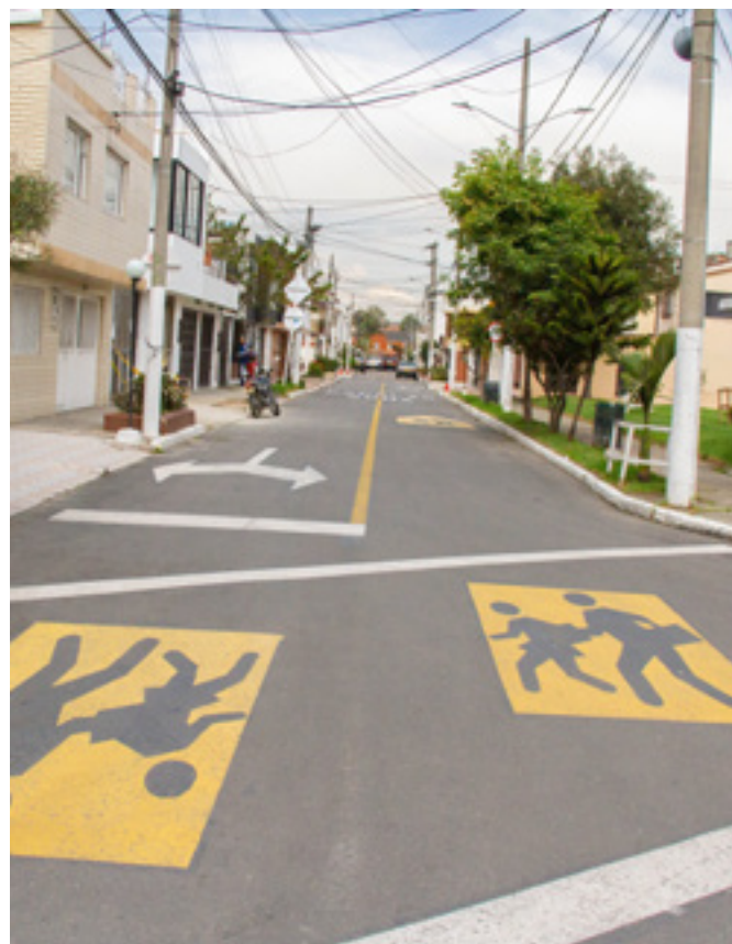
Foto 2: Intervención en malla vial local Fuente: UMV
