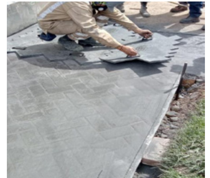
Foto 3: Intervención con tecnología de concreto estampado Fuente: UMV
