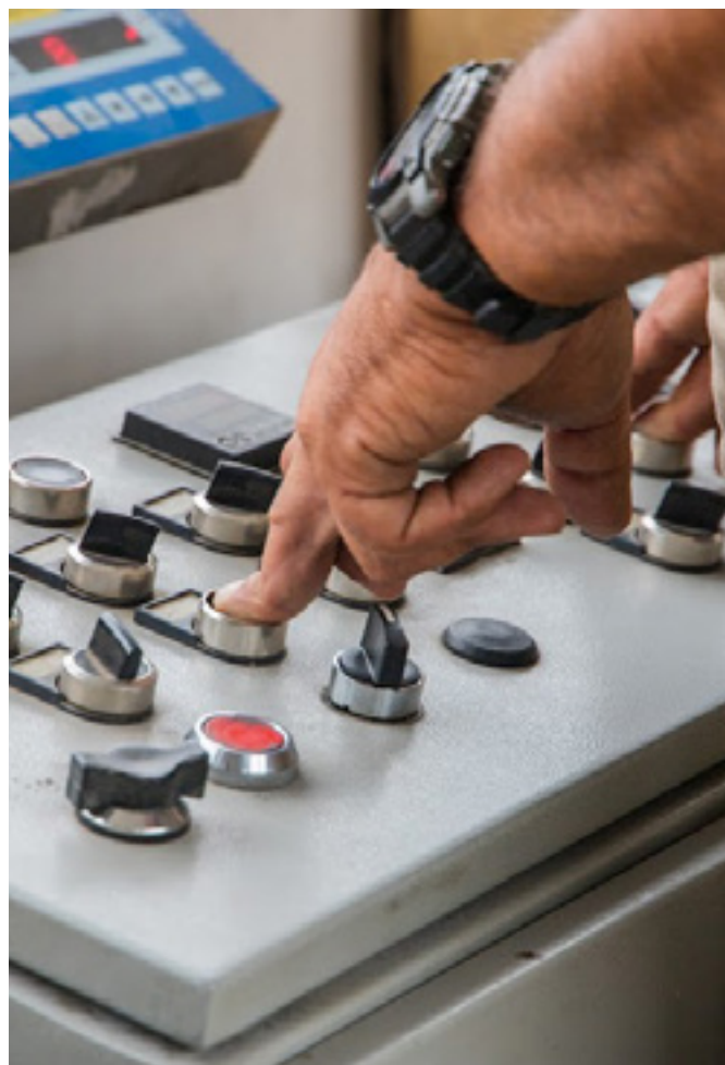
Foto 3: Operario sede de producción Fuente: UMV
