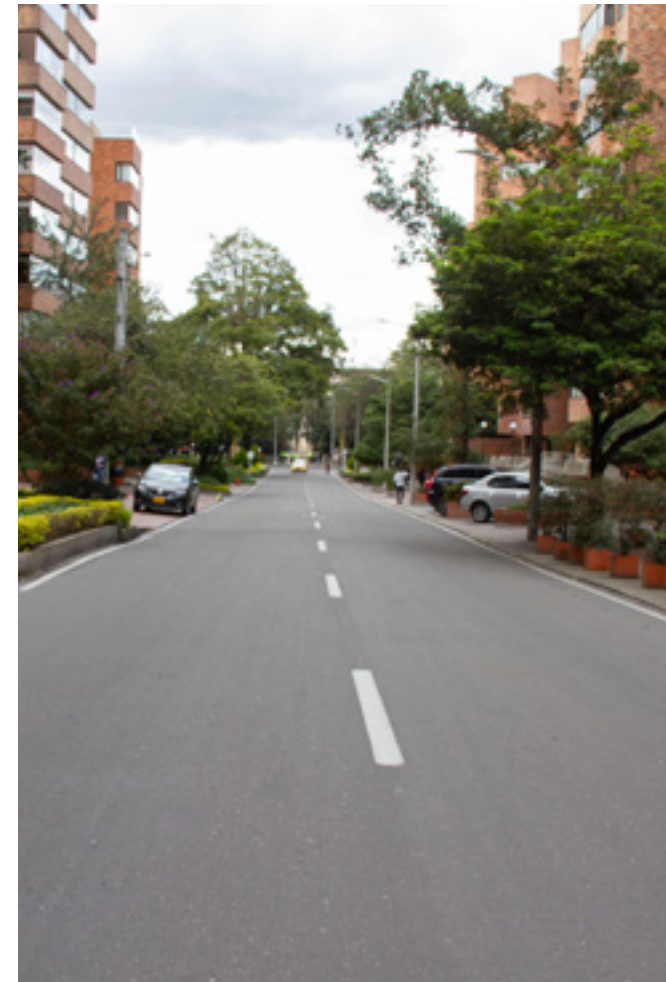
Foto 5: Intervención en malla vial arterial Fuente: UMV
