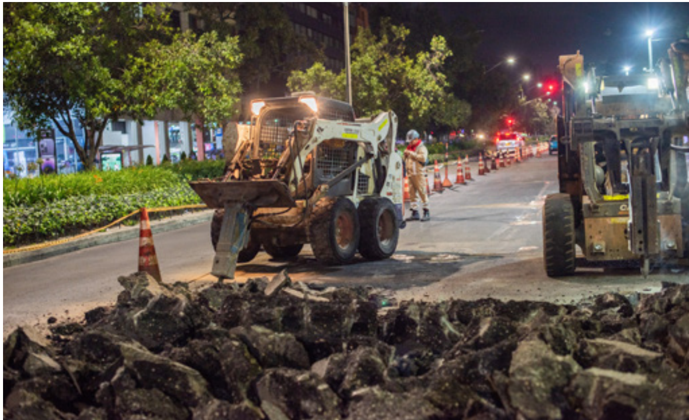
Foto 4: Trabajadores en obra nocturna Fuente: UMV
