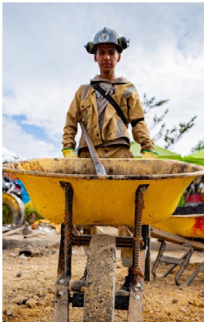
Foto 5: Trabajador en obra Fuente: UMV
