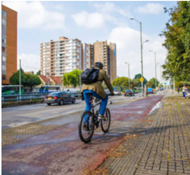
Foto 2: Tramo de prueba ciclorruta Fuente: UMV
