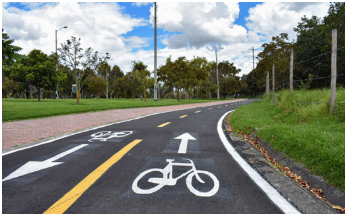
Foto 1: Intervención en ciclorruta de alameda Fuente: UMV
