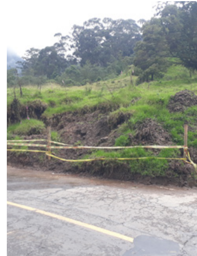
Foto 3: Intervención bioingeniería vía a Choachi Fuente: UMV
