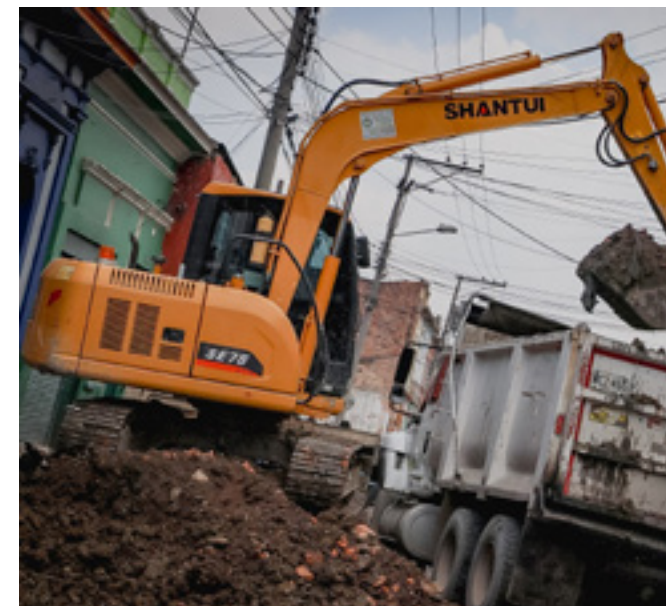
Foto 5: Retroexcavadora a frentes de obra Fuente: UMV
