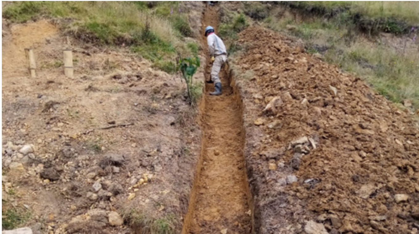
Foto 2: Tramo choachi 1 Fuente: UMV
