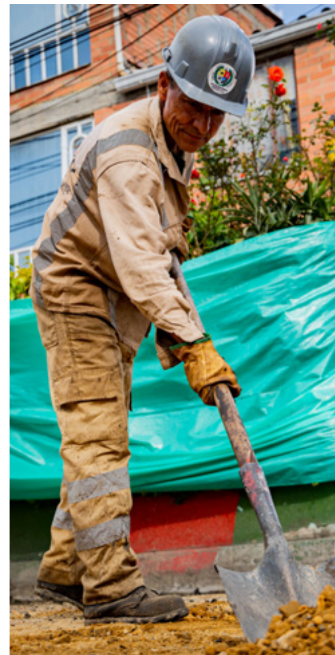
Foto 3 : Operario en obra Fuente: UMV
