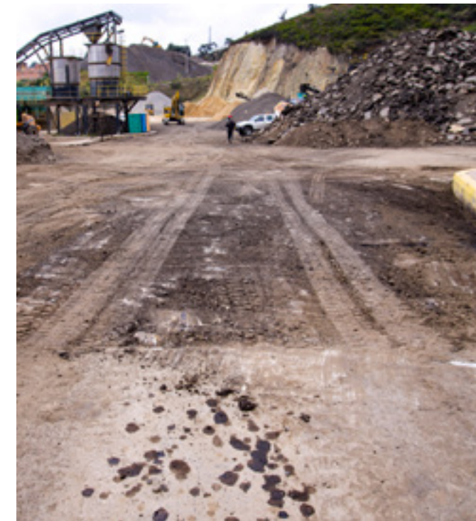
Foto 5: Tramo de prueba planta de la UMV Fuente: UMV
