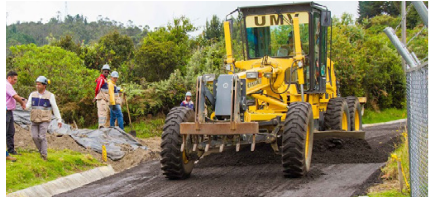
Foto 2: Obra en malla vial rural Fuente: UMV
