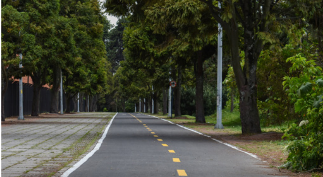
Foto 6: Intervención en ciclorruta de alameda Fuente: UMV
