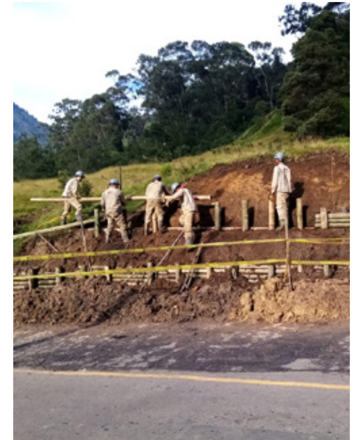
Foto 4: Intervención bioingeniería vía a Choachi Fuente: UMV
