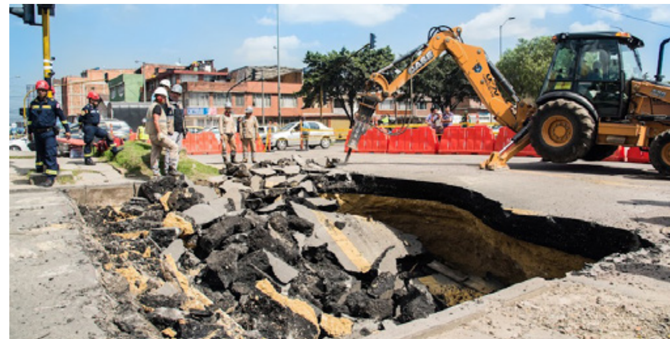
Foto 5: Intervención en malla vial arterial Fuente: UMV
