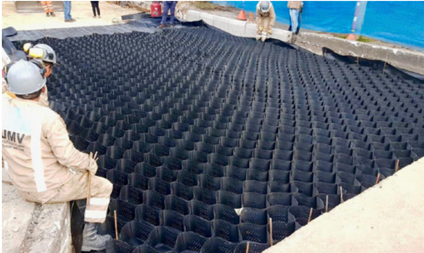
Foto 2: Instalación de geoceldas UMV Fuente: UMV
