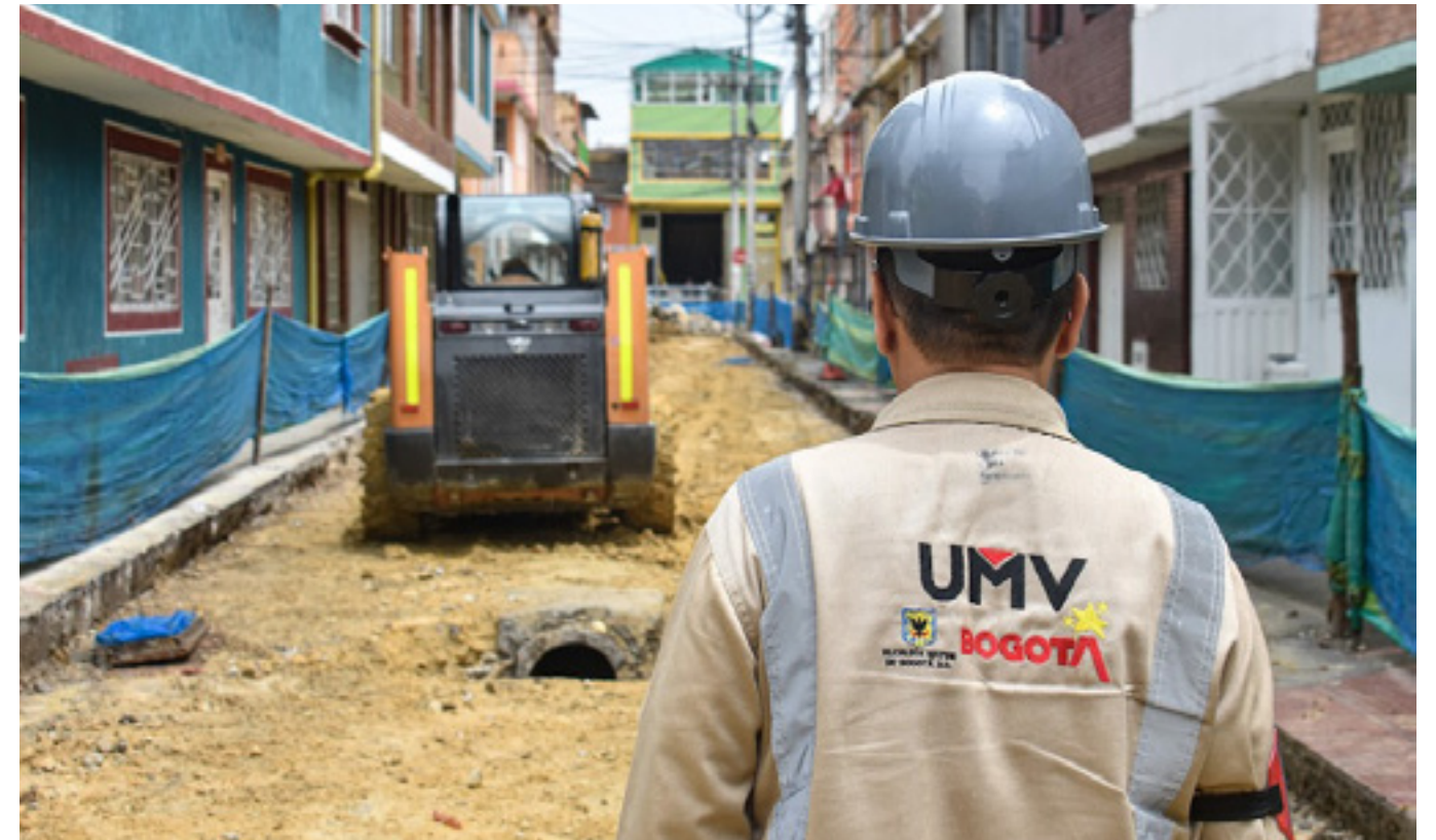
Foto 6: Trabajador en obra Fuente: UMV
