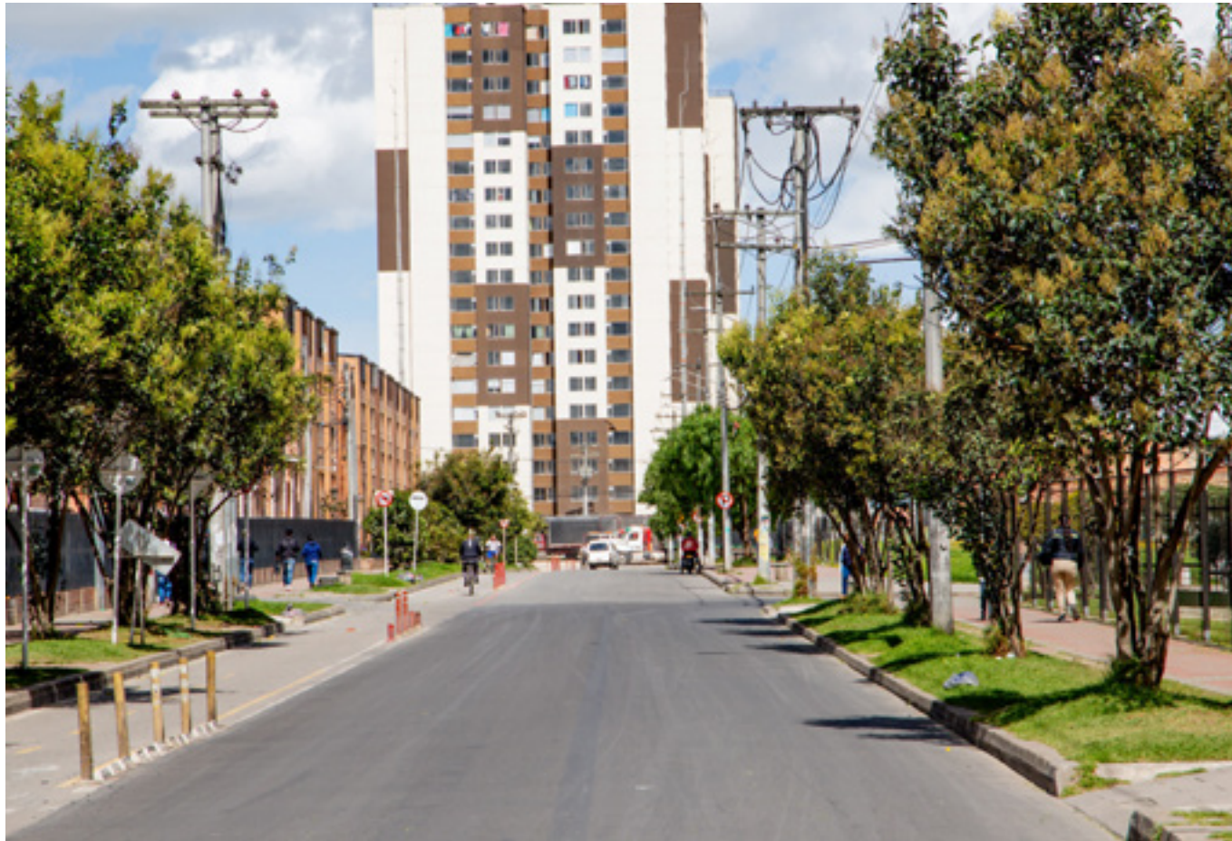
Foto 4: Intervención terminada Fuente: UMV
