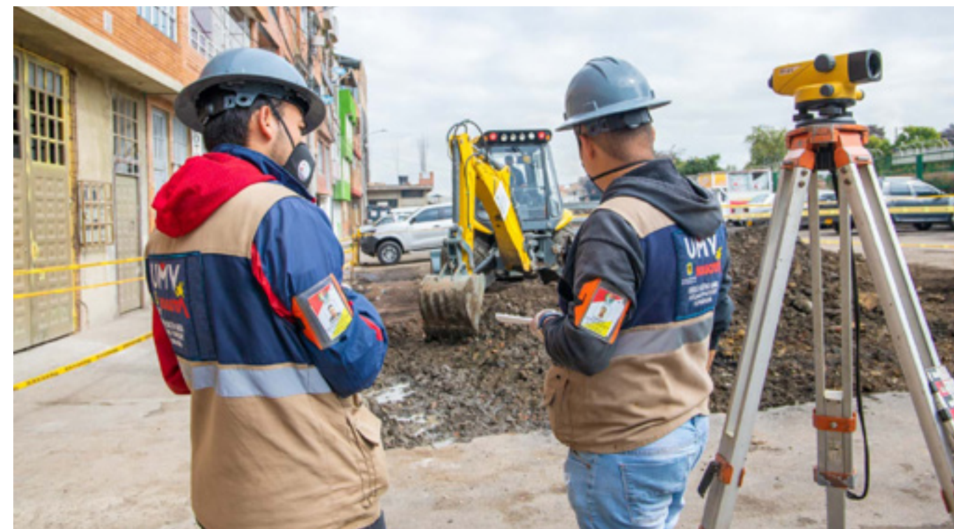
Foto 1: Topógrafos en obra Fuente: UMV
