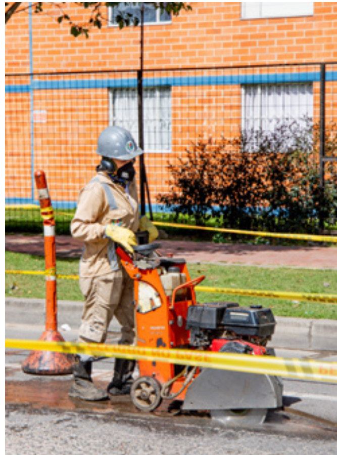
Foto 3: Operaria en obra Fuente: UMV
