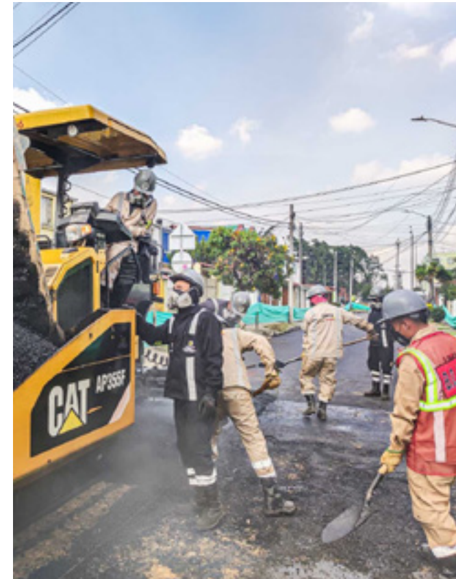
Foto 3: Intervención en malla vial Fuente: UMV
