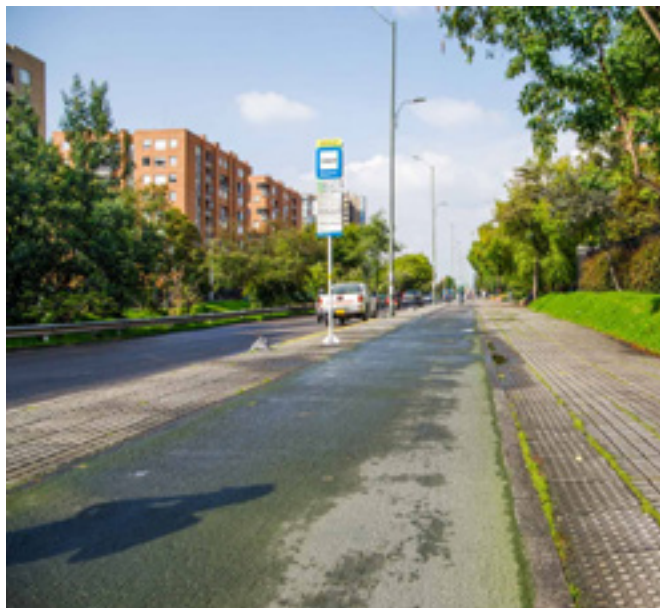
Foto 3: Tramo de prueba ciclorruta Fuente: UMV
