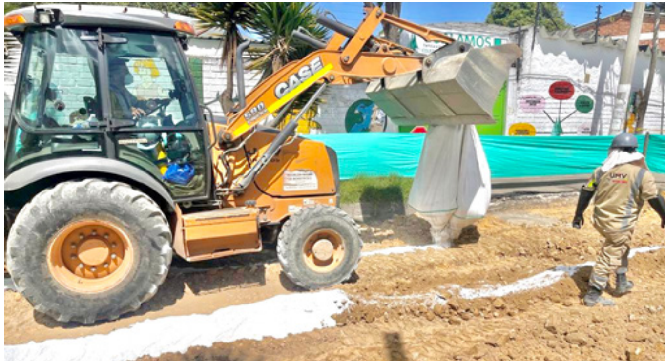
Foto 4: Aplicación de cal en vía a cargo de la UMV Fuente: UMV
