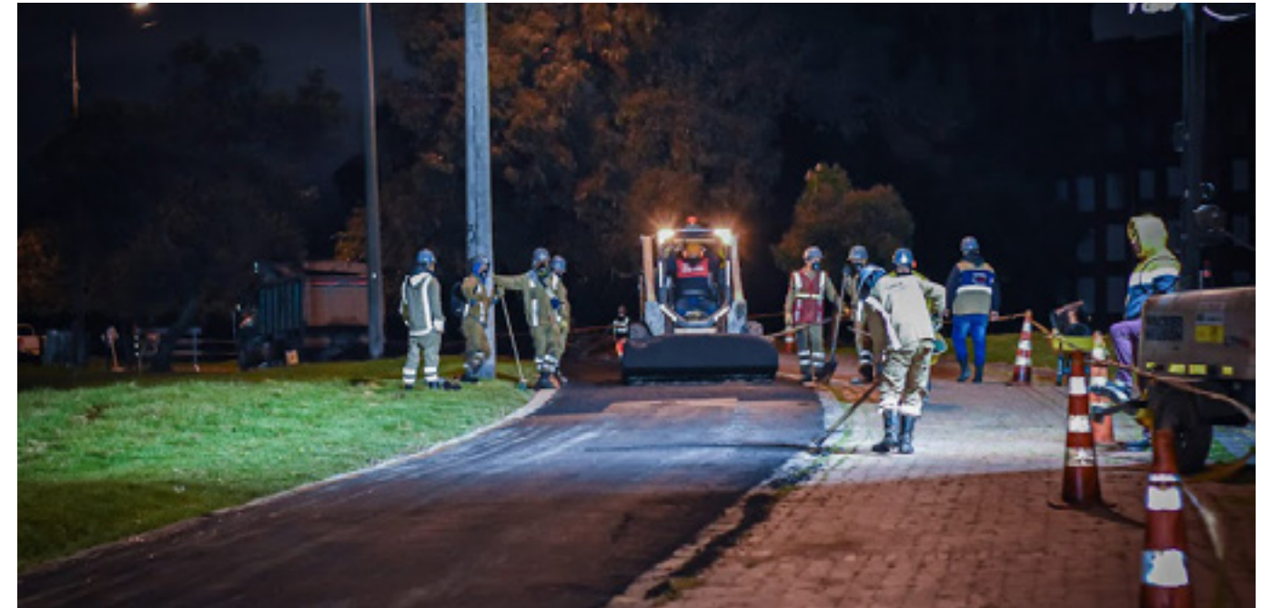
Foto 2: Intervención nocturna en ciclorruta Fuente: UMV
