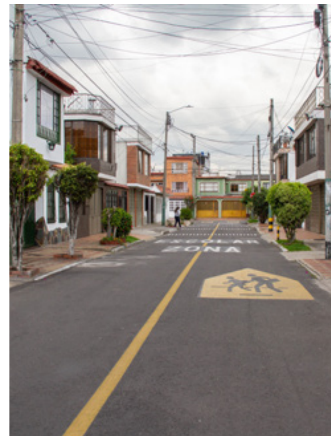
Foto 2: Intervención en malla vial local Fuente: UMV
