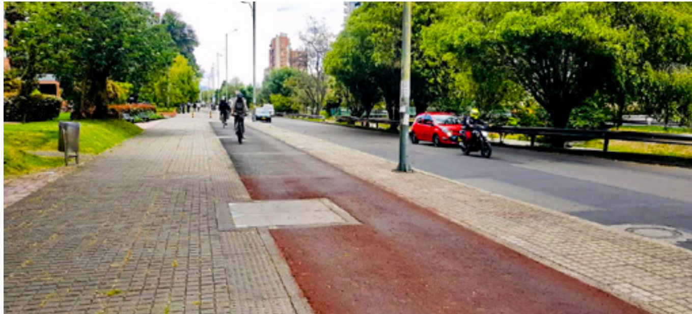
Foto 6: Tramos recién terminados Fuente: UMV
