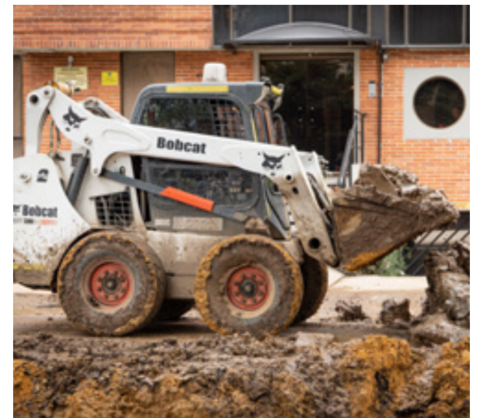
Foto 6: Minicargadores a frentes de obra Fuente: UMV
