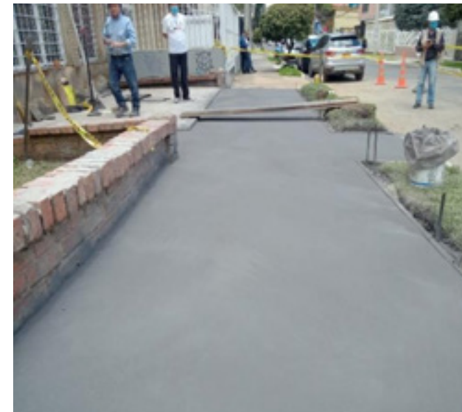
Foto 2: Intervención con tecnología de concreto estampado Fuente: UMV
