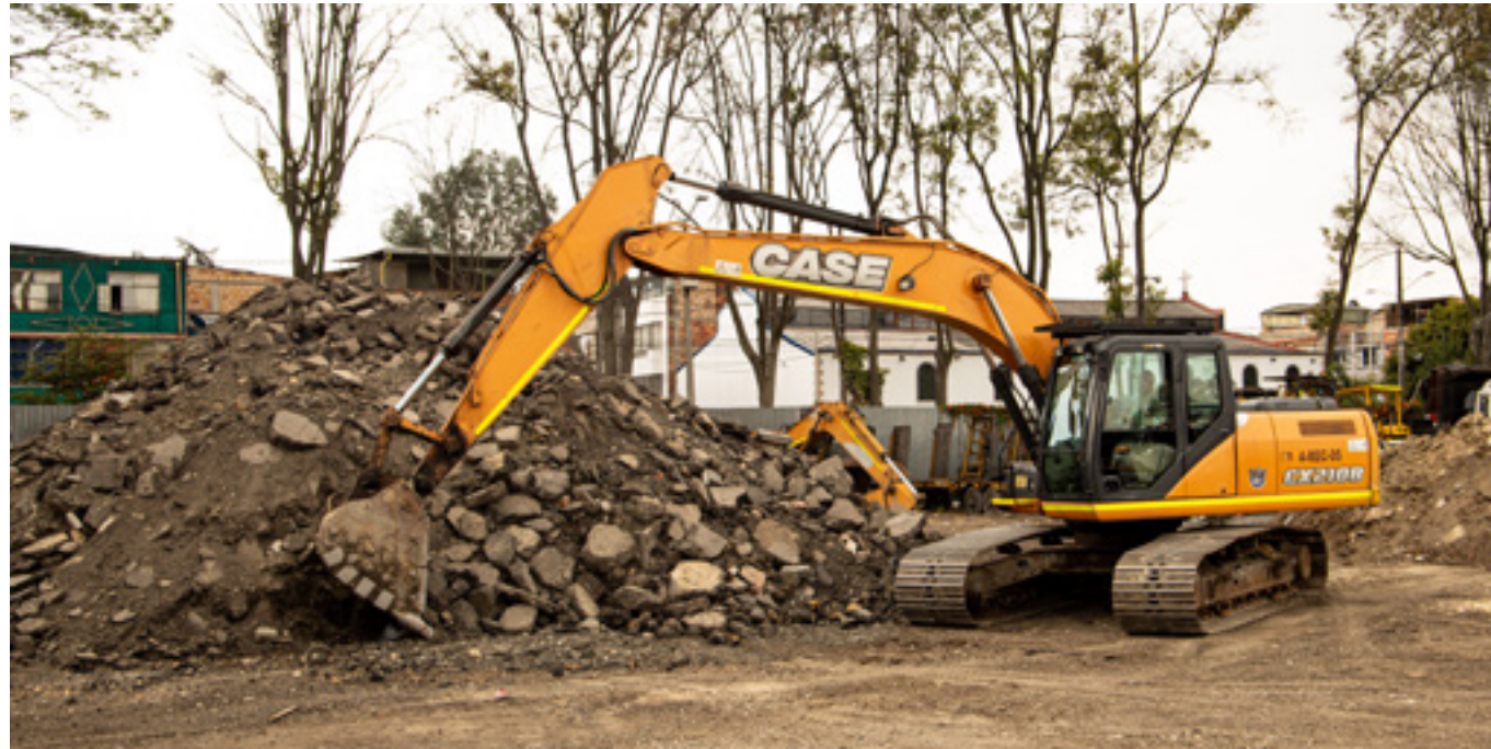
Foto 1 : Retroexcavadora en obra Fuente: UMV
