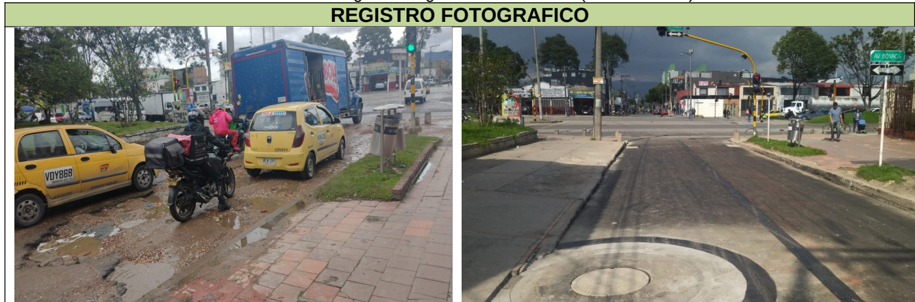
Ilustración 1. Registro fotográfico CIV 8013547 (Rehabilitación)
