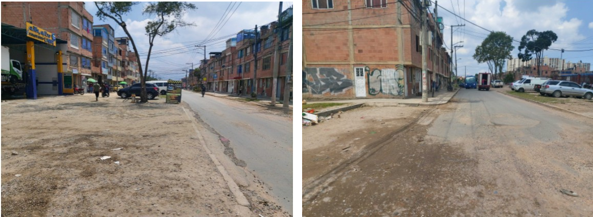
Figura 1 – Calle 34A Sur entre Carrera 91 y Carrera 91BIS
