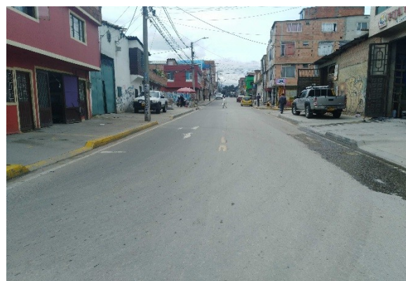
Calle 56 Sur entre carrera 80D y carrera 80G
