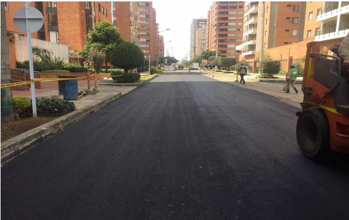
CALLE 119ª ENTRE CARRERAS 57 Y 58 DESPUES DE LA INTERVENCION foto No 7
