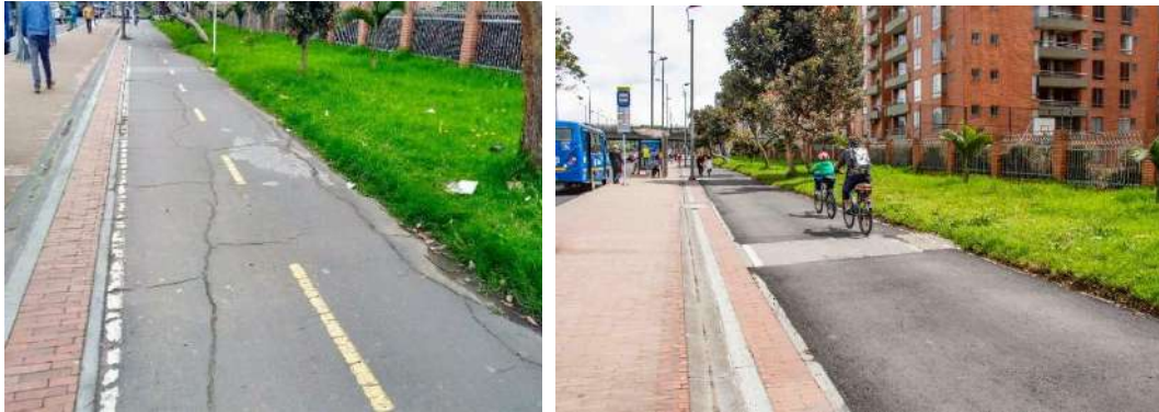
Fotografía 5. intervención Avenida Boyacá entre Calle 26 y Avenida las Américas. ANTES DESPUÉS
