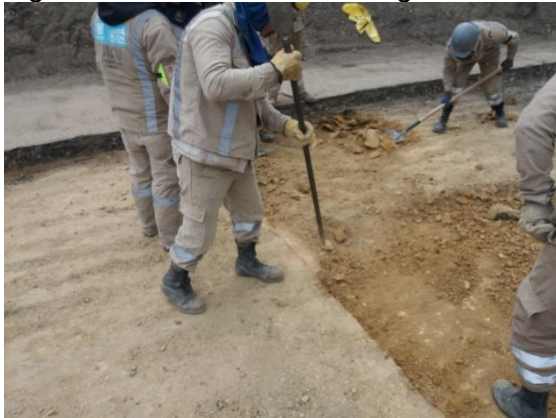
Figura 19 Instalación de base granular
