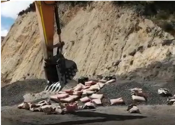
Figura 14 Adición de cemento al RAP
