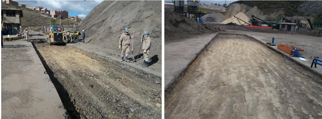
Figura 17 Demolición y retiro de la carpeta asfáltica
