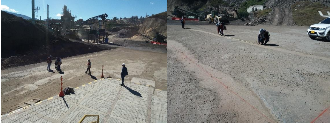
Figura 16 Localización y replanteo tramo de prueba
