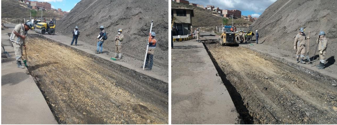
Figura 18 Retiro de la carpeta asfáltica y del material granular remanente
