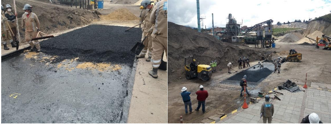
Figura 20 Instalación de mezcla asfáltica.
