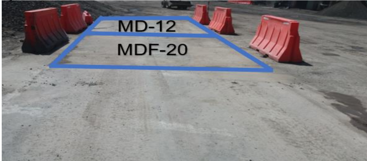
Figura 6 Localización de las estructuras de pavimento
