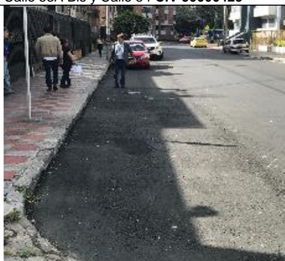
Foto No 6: Se observa pavimentada la bahía de parqueo ubicada en la Carrera 36A entre AC 53 y Calle 53A Bis CIV 50006424
