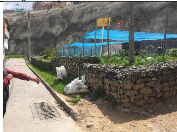
Gaviones instalados
