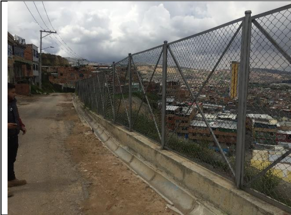
Cerramiento y Cunetas construidas
