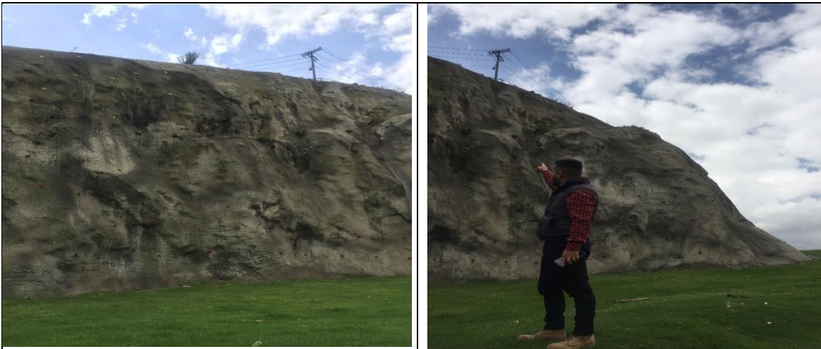
Concreto lanzado
