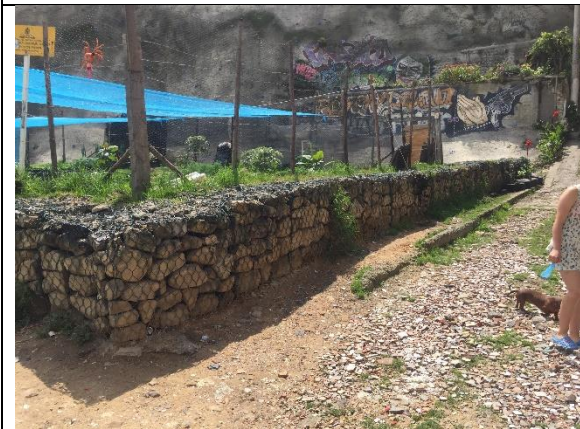
Gaviones instalados
